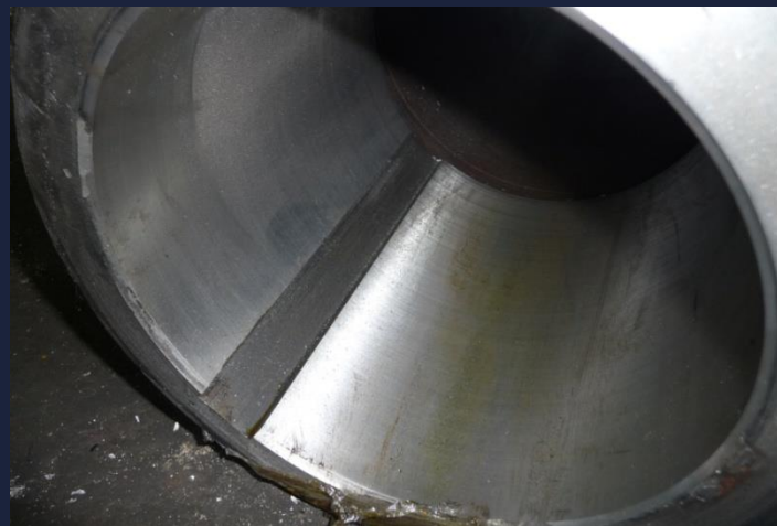
Восстановленная внутренняя поверхность
