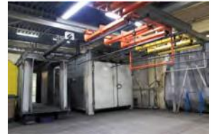
Teilautomatisierte Linie der Pulverbeschichtung
