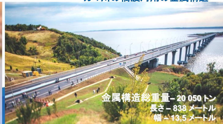
カマ川の橋渡河用の金属構造
