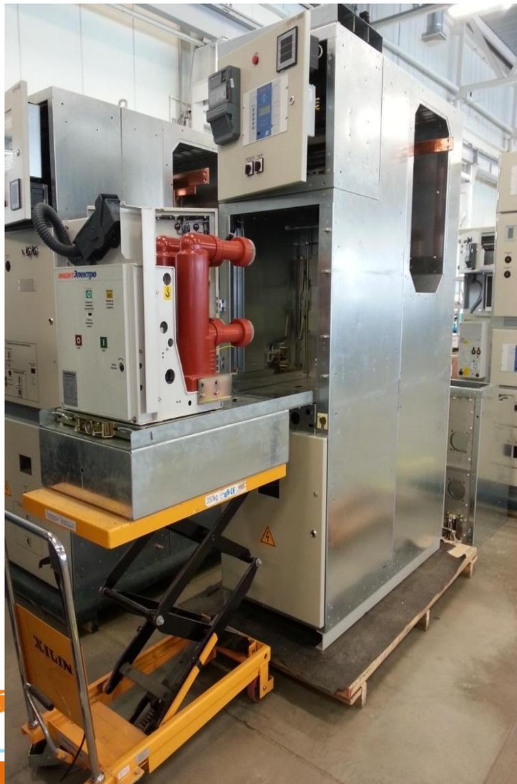
Le dispositif de distribution de l'appareillage de commutation préfabriqué "INVEL" 6(10)kVt muni de l'interrupteur à vide "INVEL" produit par "INVENT-Elektro".
