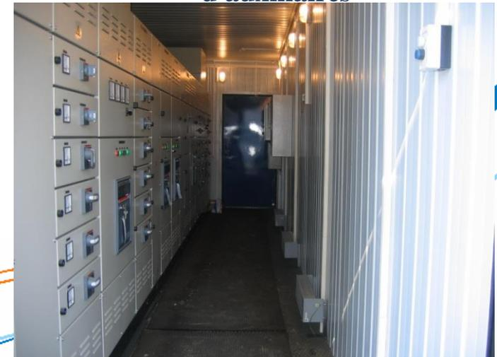
L'armoire des dispositifs de distribution à basse tension
