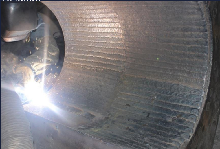
La déposition de la face interne d'une demi-chambre
