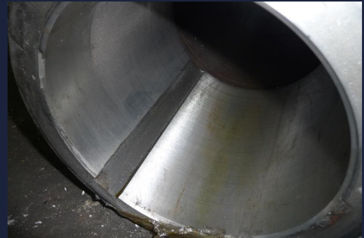
La surface interne restaurée
