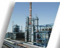
L'installation électrique de dessalement-7
