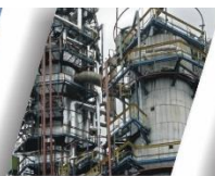
L'installation de viscoréduction du goudron
