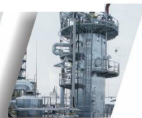
L'installation du bitume
