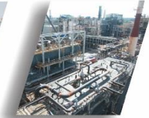
L'installation de la production du soufre élémentaire
