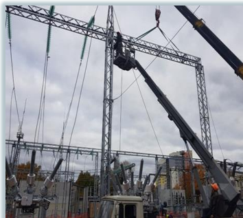
«Свердлау» подстанциясен реконструкцияләү, «Үзәкнең һәм Идел буеның төбәкара бүлөп тарату чөлтәр компаниясе», Түбән Новгород шәһәре
