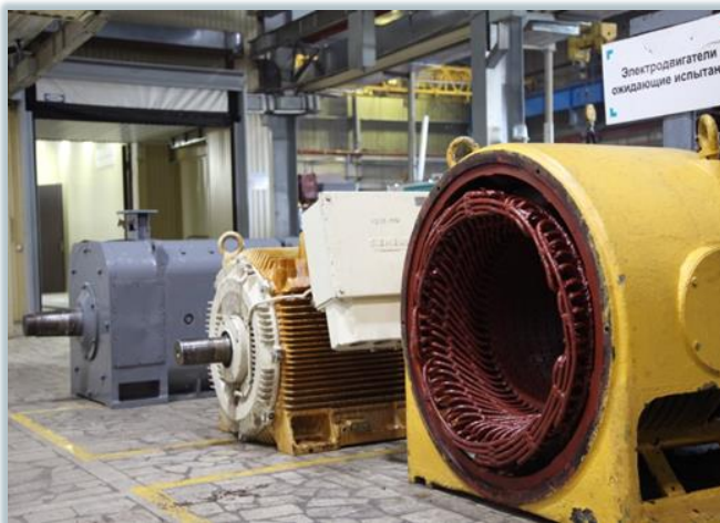
Электр двигательләрен һәм генераторларын ремонтлау заводы
