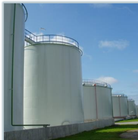
600 000 м 3 артык резервуар
