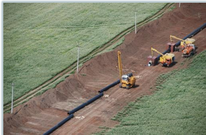
Магистраль нефтьүткәргеч төзү "Транснефть-Прикамье" АЖ.
