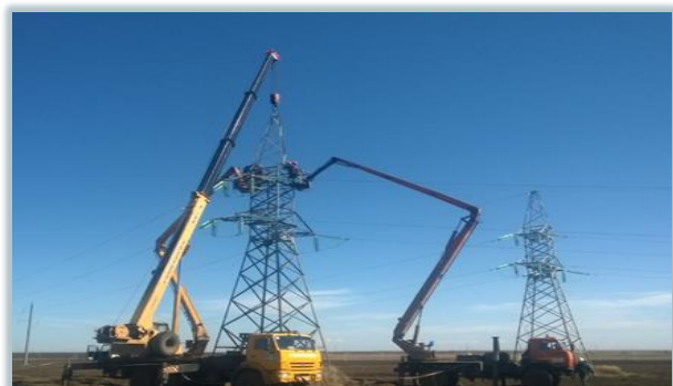
ВЛ-110 (югары вольтлы линиясен) төзү «Газпромнефть-Оренбург» ЖЧЖ
