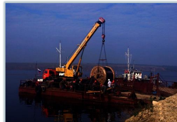
Чулман елгасы төбөнән 6 кВлы диңгез кабеле сузу, "Татнефть" ГАҖ
