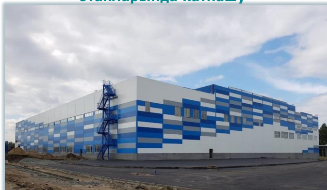
Чилэбе шәһэрэндэ Урал махсус арматура төзү заводы («УЗСА» ЖЧЖ)
