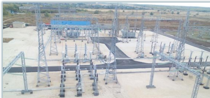
220 кВ «Яңарыш» подстанциясен реконструкцияләү, «Бердәм энергетика системасы федераль чөлтәрләр компаниясе» ААҖ филиалы - Идел магистраль энергетика чөлтәрләре, Саратов өлк.
