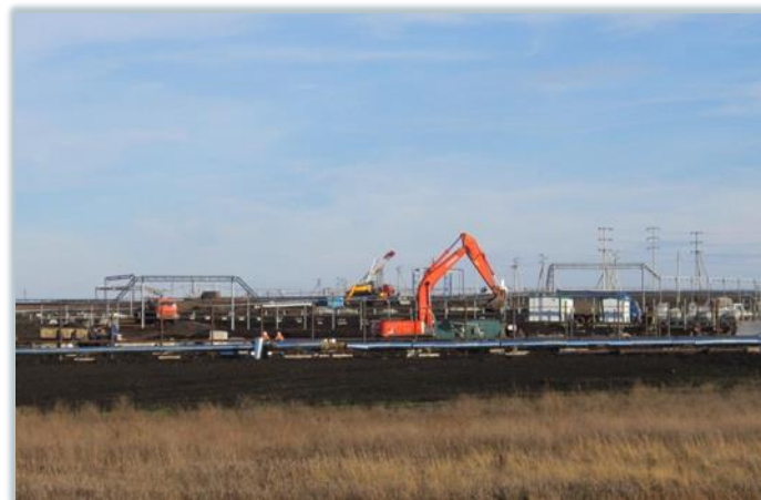
「Tatneft-サマラ」 源池の建設
