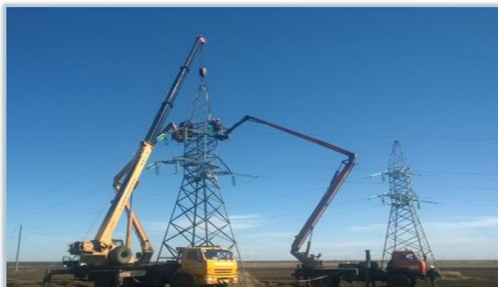
VL-110 の建設 LLC「Gazpromneft・オレンブルク」»
