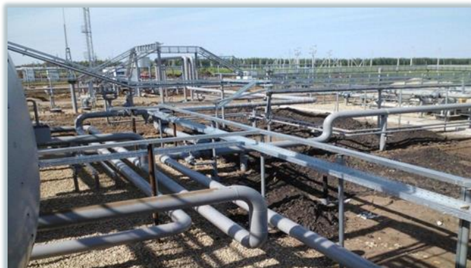
油ポンプステーション 1 (NPS-1) PJSC 「Tatneft」 の建設
