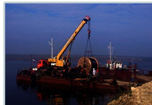
海底ケーブル ガスケット 6 kV 川釜、 LLC「Tatneft」の下部に整備
