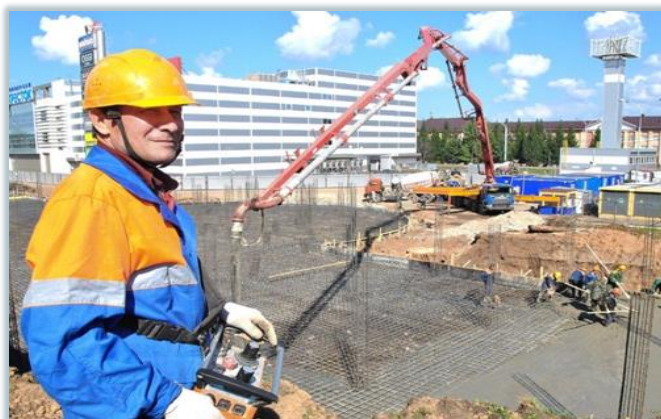
地下駐車場階層のショッピング/エンターテイメントセンターの建設
