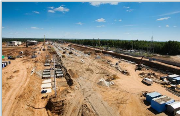
石油ガス建設
