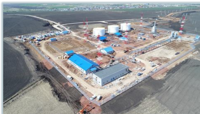
「Sheshma Kalikino」 タンクの建設
