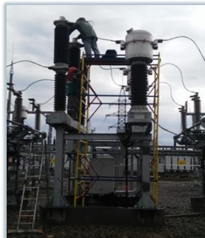
155 変電所の建設 「Bolshekamenskaya」 PJSC「Tatneft」
