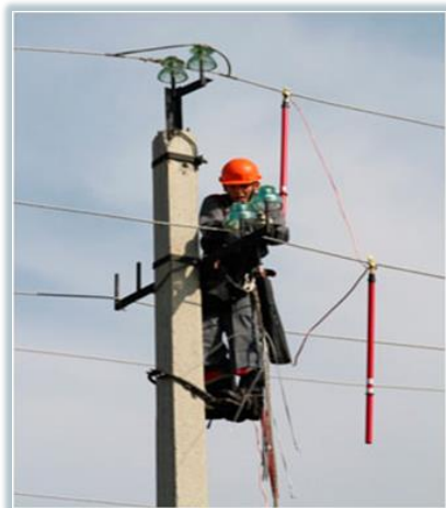
VL-6 (10), 35, 100 kV – 17 193キ口
