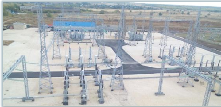
La reconstruction de la sous-station 220 kW "Vozrozhdeniye" / la revitalisation, la filiale de "OAO la Société Fédérale du Réseau National Unifiée Électrique", la région de Saratov.
