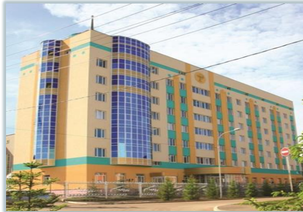
La construction du bloc chirurgical de soin de l'hôpital de premier secours de "PAO Tatneft"
