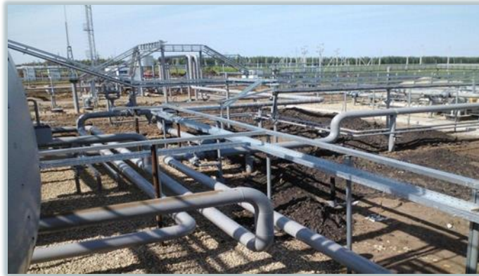
La construction de la station de trafic du pétrole – 1 (NPS-1) de "PAO Tatneft"
