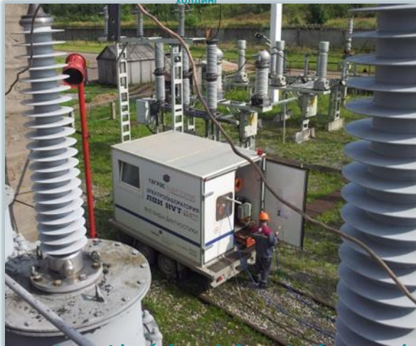
Le montage et le réglage de la protection par relais, le système automatisé du comptage commercial de l'énergie électrique de la sous-station 110/10/6 kW "Sverdlovskaya", "Les réseaux électriques centraux", "Nijnovenergo" Nijny-Novgorod
