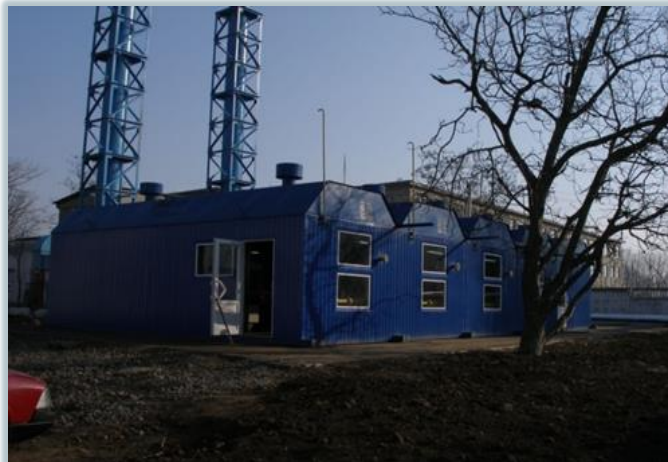
La maintenance de 18 installations de forage par le biais des installations des chaudières ПKH-2M
