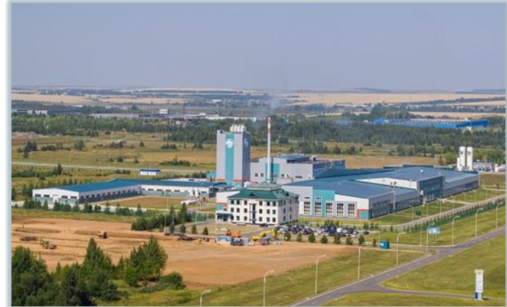
La construction "clés en main". de l'usine de "OOO P-D Tatneft-Alabouga Steklovolokno" / la production de la fibre de verre
