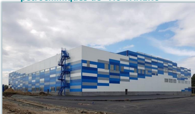
La construction de l'usine uralienne de la construction de l'armature ("OOO UZSA") dans la ville Tchelyabinsk
