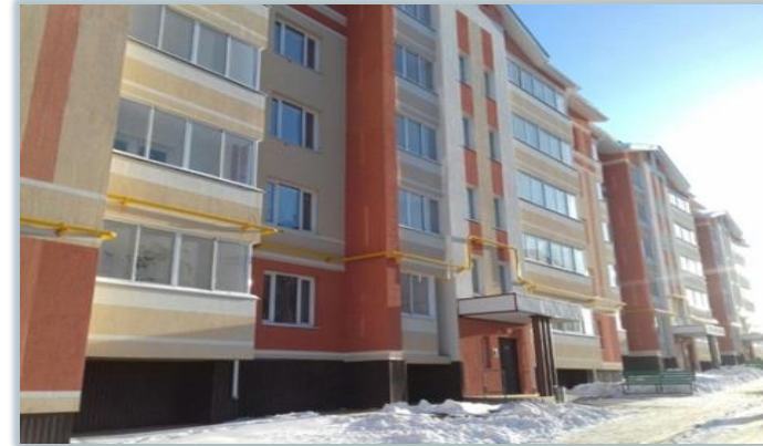
La construction des ensembles résidentiels pour les employés de "PAO Tatneft" et du fonds publique résidentiel de la République de Tatarstan
