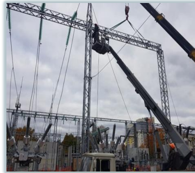
La reconstruction de la sous-station "Sverdlovskaya", "PAO MRSK du Centre et de Privolzhye" Nijny-Novgorod
