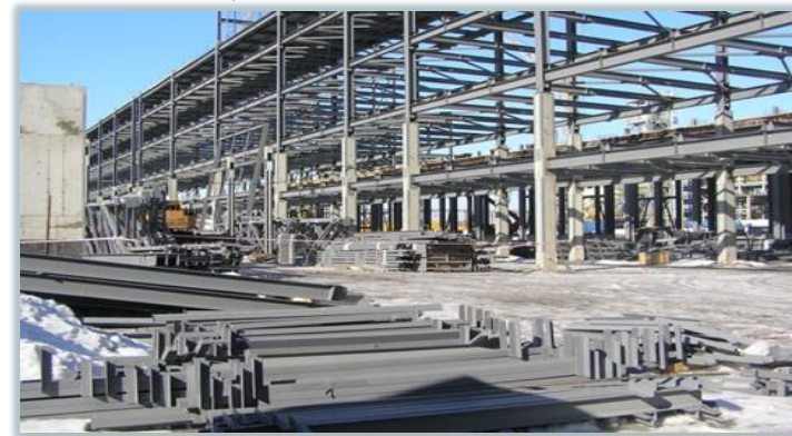
La construction des locaux technologiques sur le sol de l'usine de "PAO Nizhnekamskneftekhim"
