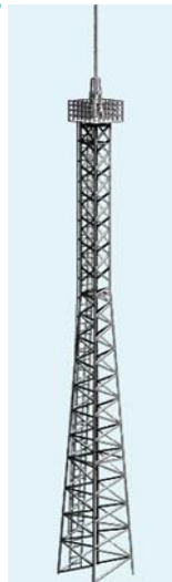
les facilités de mât d'antenne
