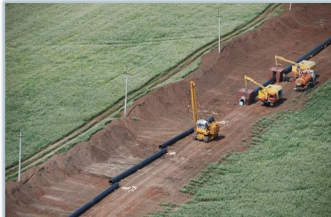
La construction de la tuyauterie pétrolière principale "AO Transneft-Prikamyé"
