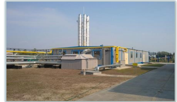
La construction du bâtiment des chaudières de 12,0 MWt "AO Yamalkommunenergo" la ville Tarko-Sale
