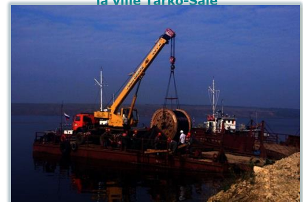
La pose de câble marin de 6 kW à travers du plafond de la rivière Kama, "PAO Tatneft"
