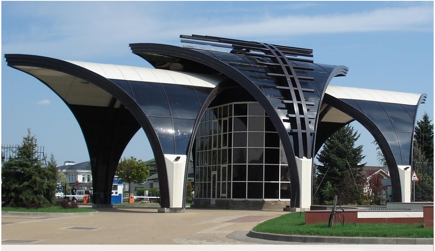
Kontrollpunkt von EFH-Wohnsiedlung in der Stadt Tula Monolith-Polycarbonat, bronzefarbig T 25%, Dicke 6 mm
