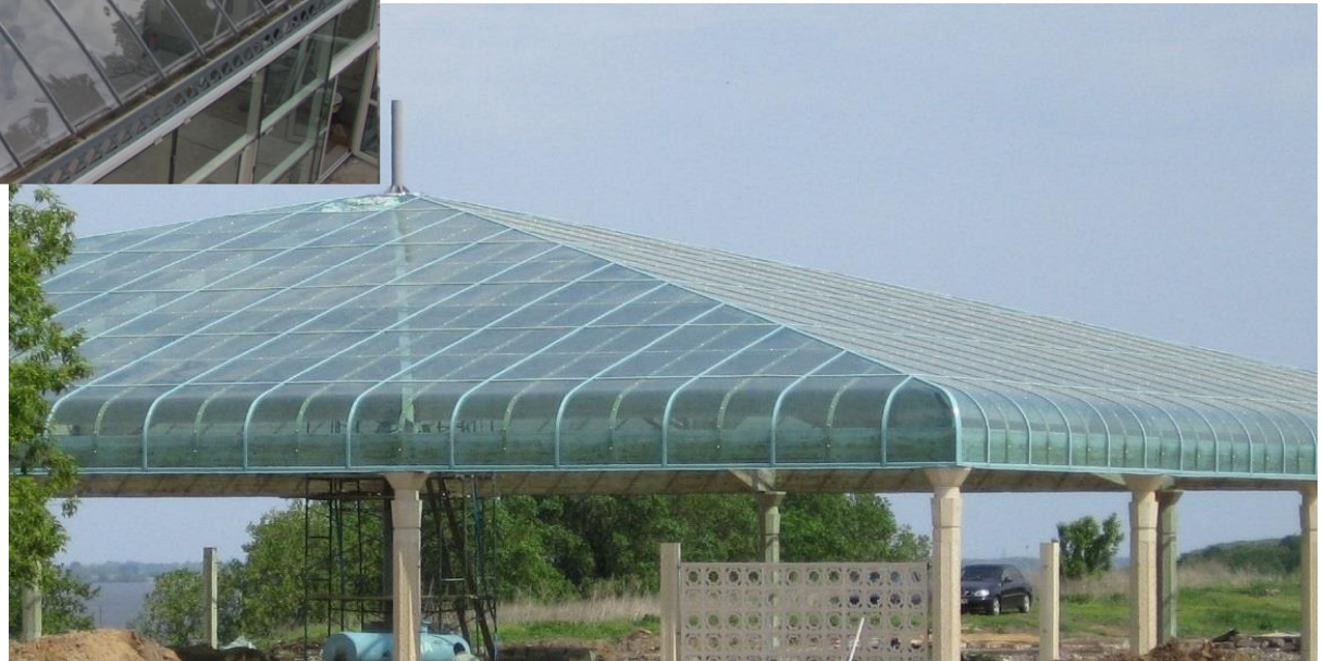
Dachdeckung über den Ausgrabungen des Khanpalastes, denkmalgeschütztes Gebiet Stadt Bulgar Monolith-Polycarbonat Novattro, Bestellfarbe grün, Dicke 6 und 8 mm
