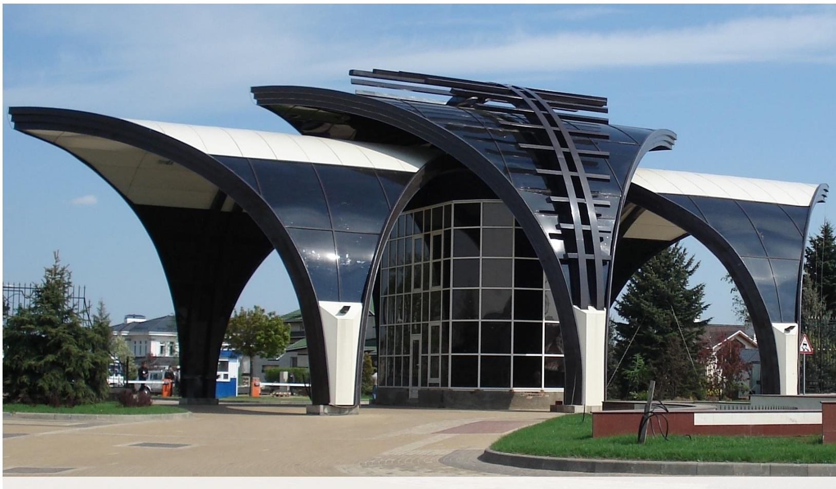
Тула ш. коттедж поселогының КПП монолит поликарбонат, бакыр төсендә Т 25%, калынлыгы 6 мм
