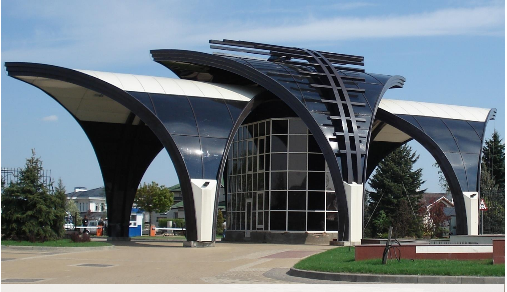
المدخل الرئيسي لمدينة سكنية في مدينة تولا بولي كربونات متجانسة / لون برونز ت 25٪ / سماكة 6 و 8 ملم
