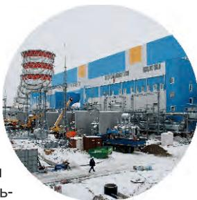
ИЦ «Энергопрогресс» выступил техническим заказчиком и генеральным проектировщиком в строительстве двух энергоблоков общей электрической мощностью 230 МВт филиала АО «Татэнерго» Казанская ТЭЦ-1.
