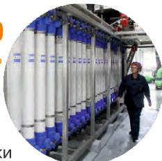
Наладка схем подготовки обессоленной воды с использованием мембранной технологии на Заинской ГРЭС и Казанской ТЭЦ-2 позволила улучшить качество обессоленной воды по удельной электрической проводимости, содержанию натрия и кремнекислоты. Экономия расхода серной кислоты и едкого натра составила 90%.
